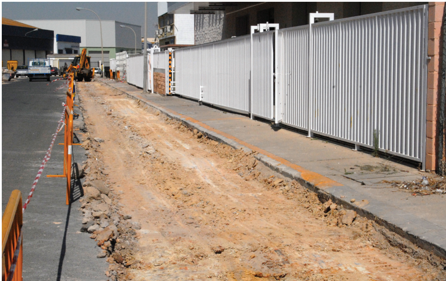
/ Arreglo del acerado
