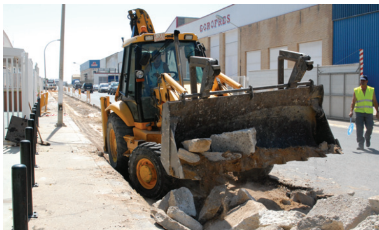
/ Arreglo del acerado
