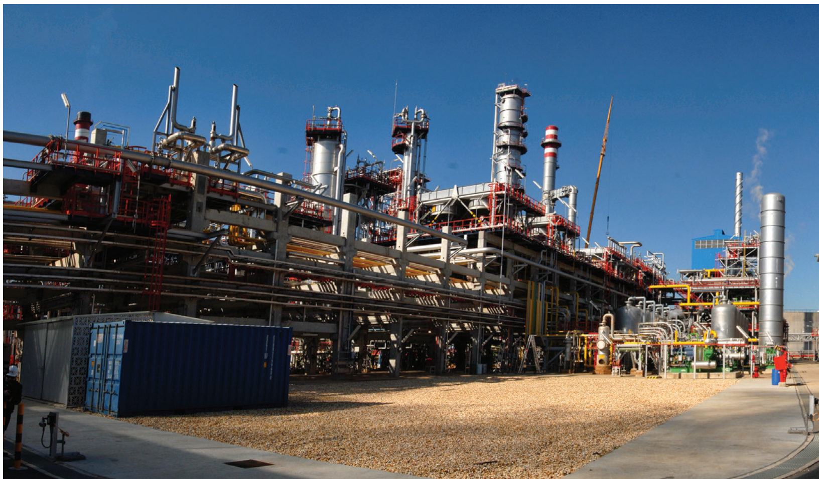
/ Panorámica de la nueva ampliación de planta de Refinería La Rábida
