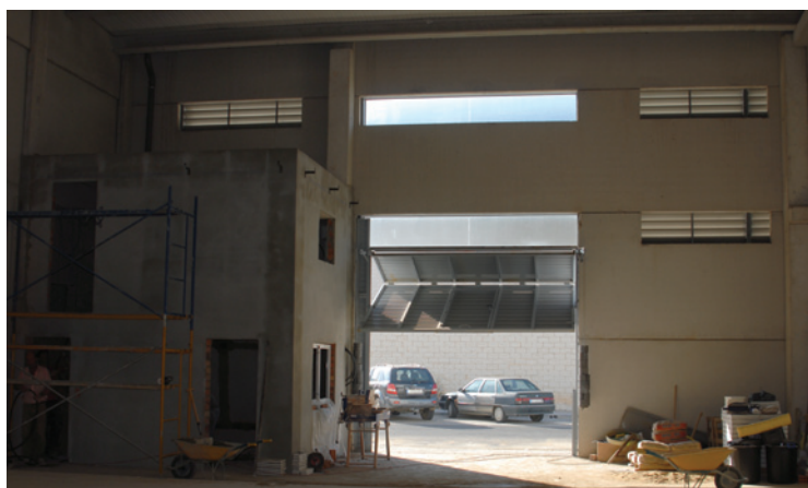
/ Obras en la nave del CIE
