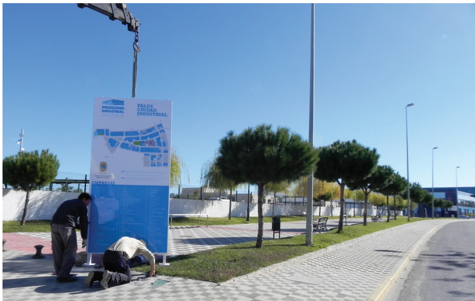
/ Instalación de totems indicativos en las distintas entradas al polígono
