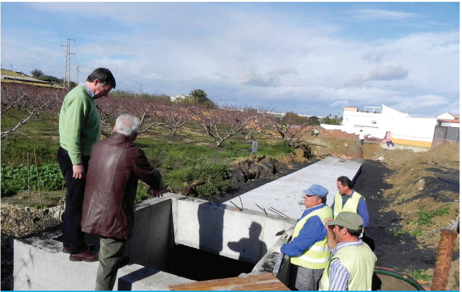
/ Soterramiento del Arroyo de la Calzadilla para la construcción del colector
